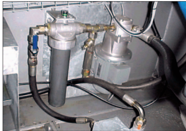
Bild 1 : Ölpumpe vor Modifikation
