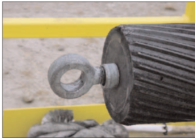
Links der Augenbolzen der Tipregulierung einer 1,5 MW Anlage, erstes Design. Der Augenbolzen riss ab, führte zu zwei schweren Flügelschäden und wurde in der gesamten Serie ersetzt - "Retrofitting". Rechts der "neue" Augenbolzen.
